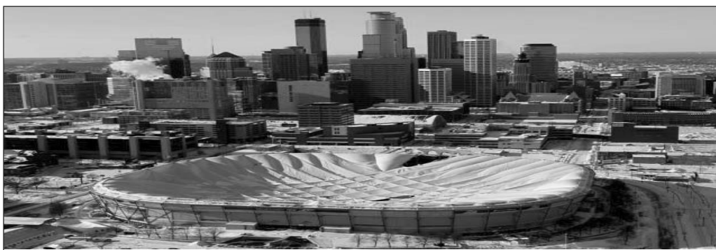
Рис. 1. Обрушение стадиона в Миннеаполисе в 2010 г.
